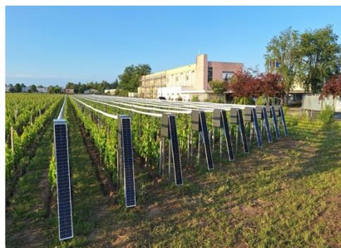
**Photo 1.** Viti-Tunnel en position rangée, rangs de vignes à l'air libre (crédit photo : Mo.Del).
