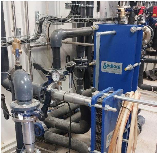
**Figura 9.** Intercambiador de calor con agua.
