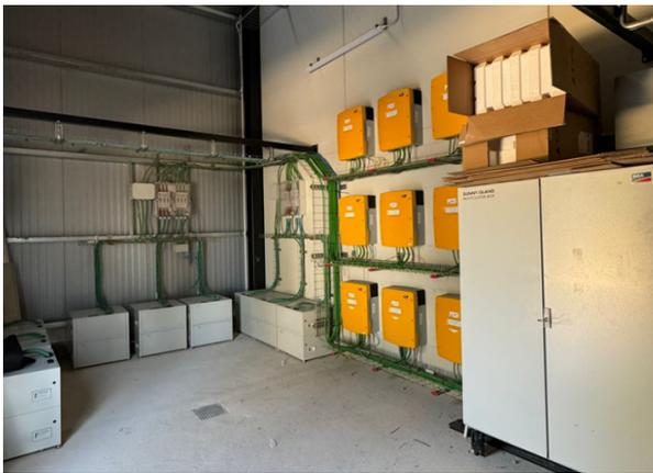
Figura 11. Sala de inversores y baterías, con formación de red.
