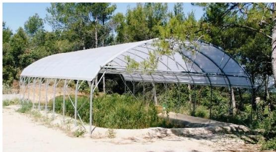
**Figure 28.** Dispositif de traitement des effluents de pulvérisation sur lit planté de roseaux, qui a fait l'objet d'un suivi expérimental de l'IFV, au Château Mont-Redon à Châteauneuf du Pape, photo J. Rochard.
