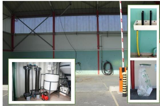
**Figure 24.** Aire collective de remplissage, lavage et traitement des effluents de pulvérisation du CSGV à Avize en Champagne créée en 2007. Un abri au-dessus des zones de lavage permet de faciliter la gestion des eaux de pluie. Photos J. Rochard
