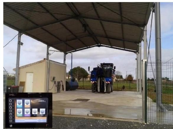
**Figure 25.** Station collective automatisée pour le remplissage et le lavage du matériel de pulvérisation et des machines à vendanger, SARL Decouzon à Teuillac en Gironde, [www.decouzon-locagri.com](http://www.decouzon-locagri.com)
