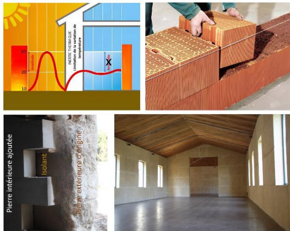
Figure 7. Principe de l'inertie thermique adapté de www.futura-sciences.com et exemple des briques alvéolaires « monomur » de grande largeur (Photo www.travaux.com ), de la pierre du Gard au Château des Hospitaliers et d'un doublage intérieur avec de la pierre locale au Château de Malleret dans le Médoc (photos J. Rochard).
