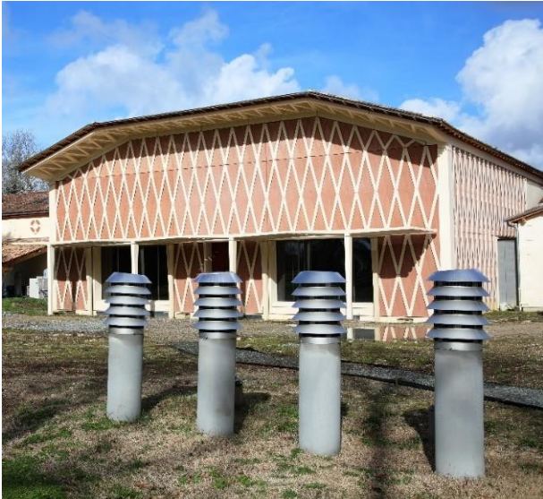
Figure 29. Vue extérieure des capteurs d'air du puits canadien au Château de Malleret, photo J. Rochard.
