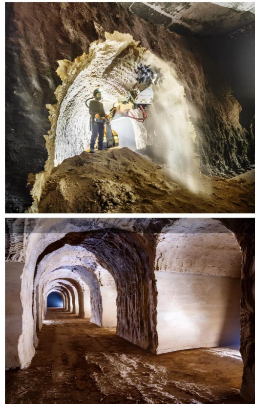
Figure 21. Creusement mécanique cave Châteauneuf-du-Pape, par l'entreprise Besson, www.espaces-souterrains.fr
